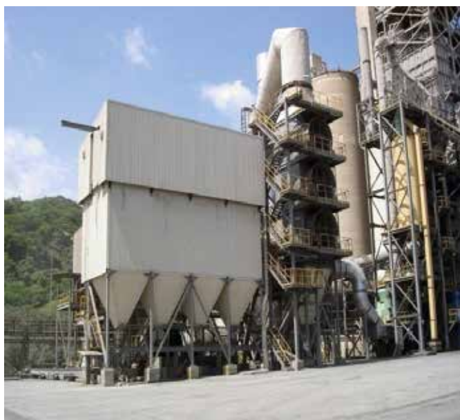
Hình 4: Cơ cấu khí vào kiểu xoáy lốc kết hợp van gió tươi của lọc bụi khí thải cooler
