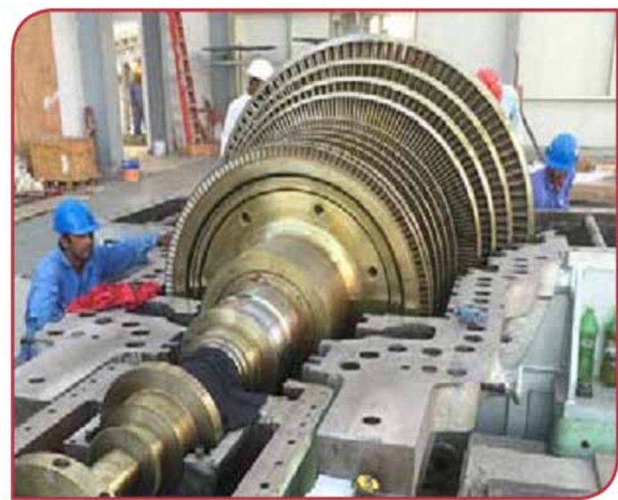
Hình 3: Tổ hợp lắp ráp tua-bin trong quá trình thi công.
