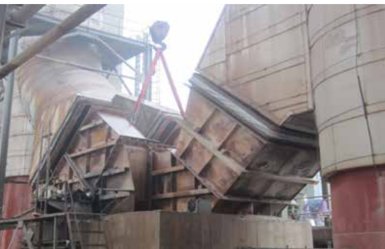
Hình 2. Hình ảnh thi công tháo cánh quạt ID cũ
