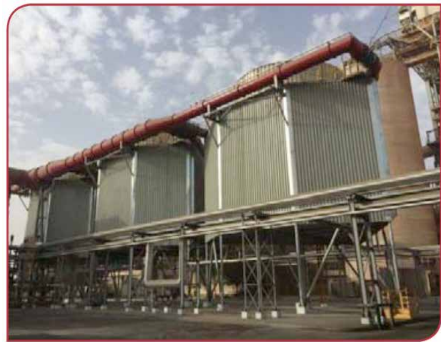
Hình 4: Toàn cảnh lắp đặt ACC
