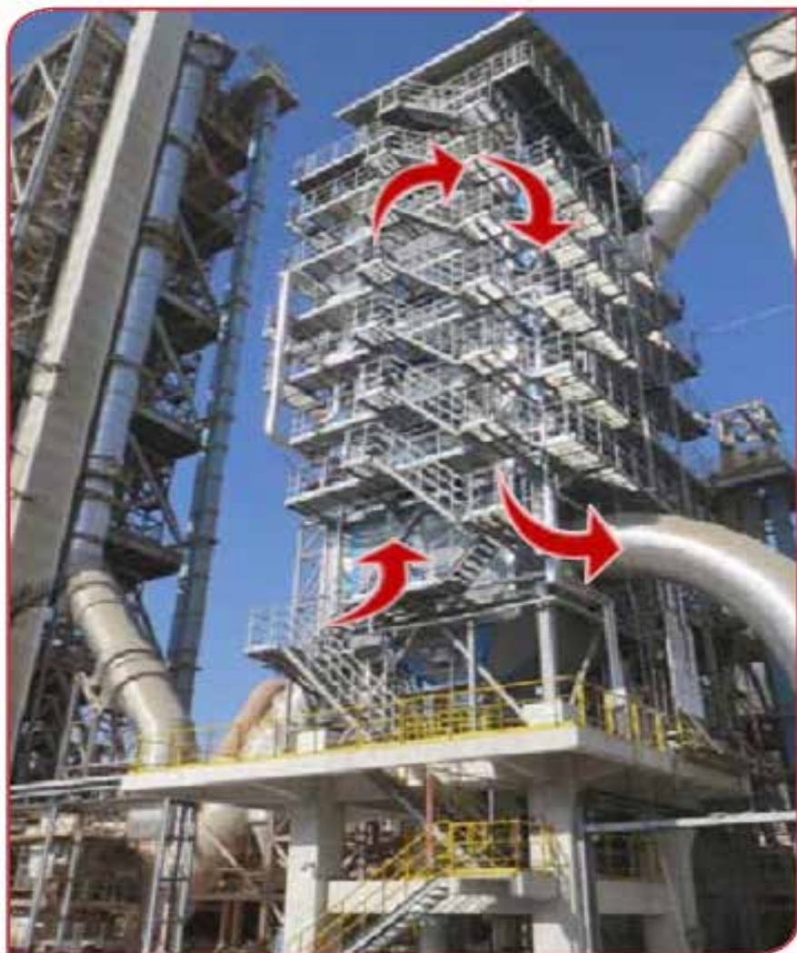
Hình 2: Nồi hơi PH trên Dây chuyền 1 có tuyến ống hình chữ U khác thường, là tuyến ống đầu tiên trên thế giới dùng cho nồi hơi PH WHR.
