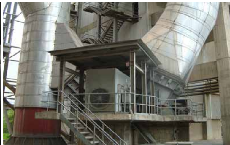
Hình 5. Hình ảnh Quạt ID đã lắp đặt hoàn thiện và chạy thử
