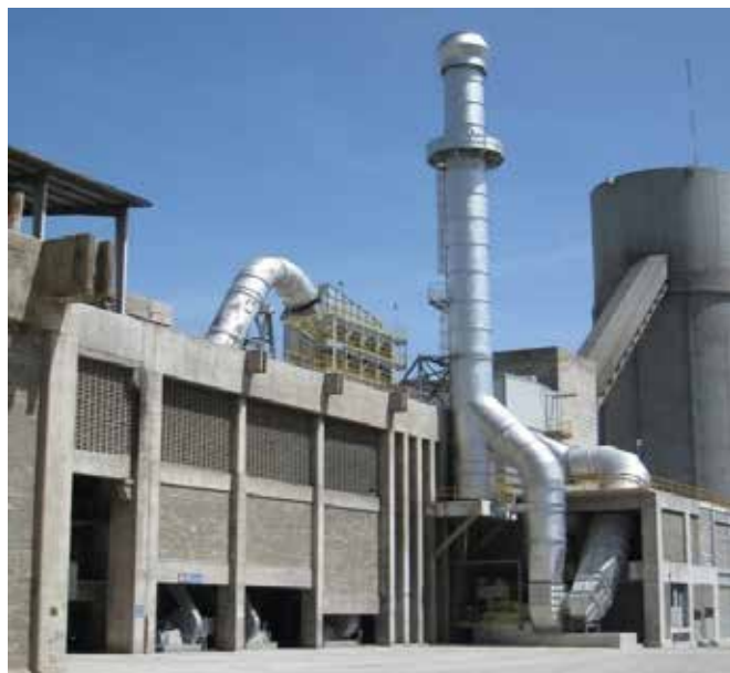
Hình 4: Cơ cấu khí vào kiểu xoáy lốc kết hợp van gió tươi của lọc bụi khí thải cooler
