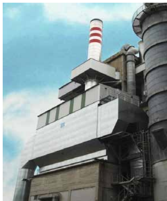
Hình 3: Bố trí lọc bụi túi tại công đoạn nghiền liệu, dùng khí nóng từ PH
