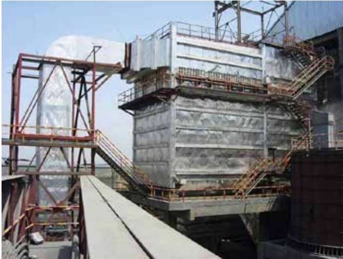
Hình 8: Hybrid filters – kết hợp giữa lọc bụi tĩnh điện và túi
