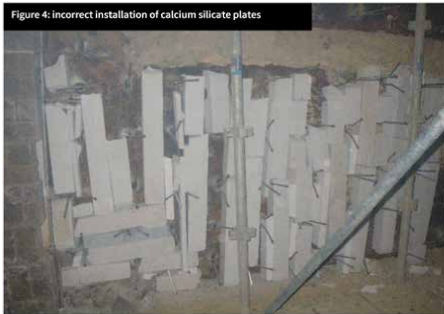
Hình 4: Lắp đặt không đúng các tấm calcium silicate
